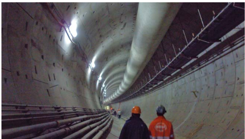
Foto15. Revestimiento de dovelas prefabricadas de hormigón. Túnel de la línea 4 - Amarella Sao Paulo.
