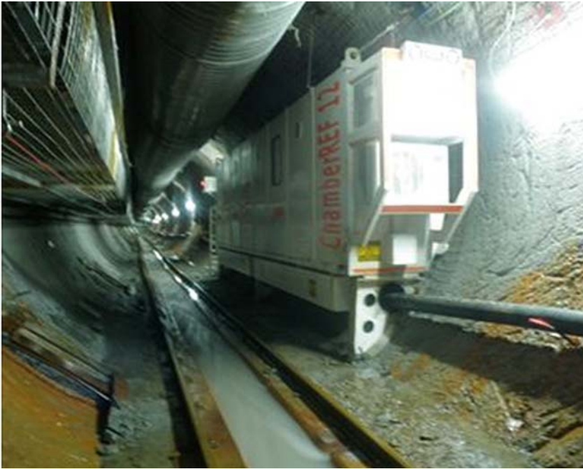
Foto 11: Imagen del interior del Túnel Sur Los Bronces, en un macizo de regular calidad geomecánica. Con soporte basado, solo en pernos de anclaje y mallas de acero eventuales en la bóveda.
