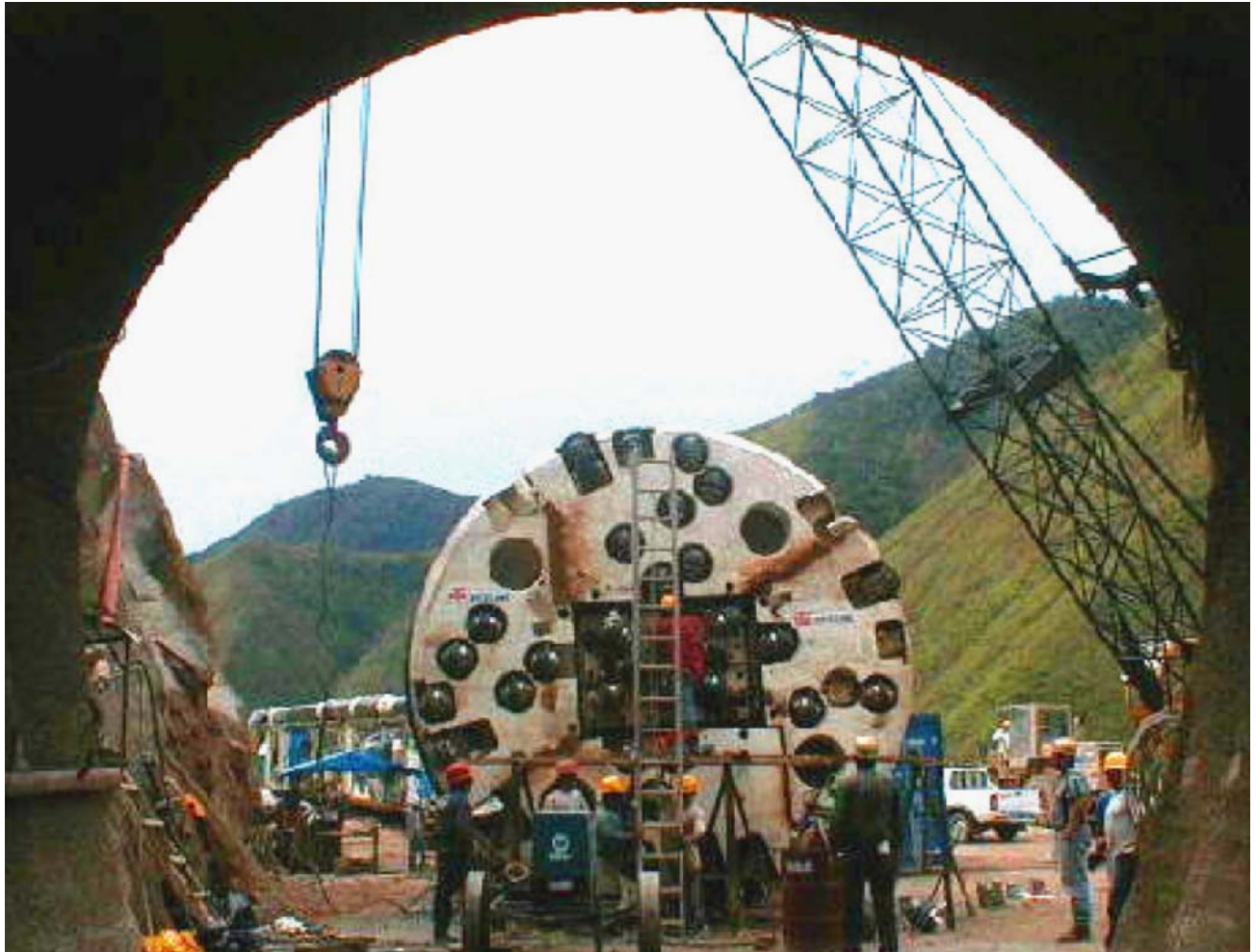
Foto 2. Montaje de la TBM Proyecto Chimay, Perú.
