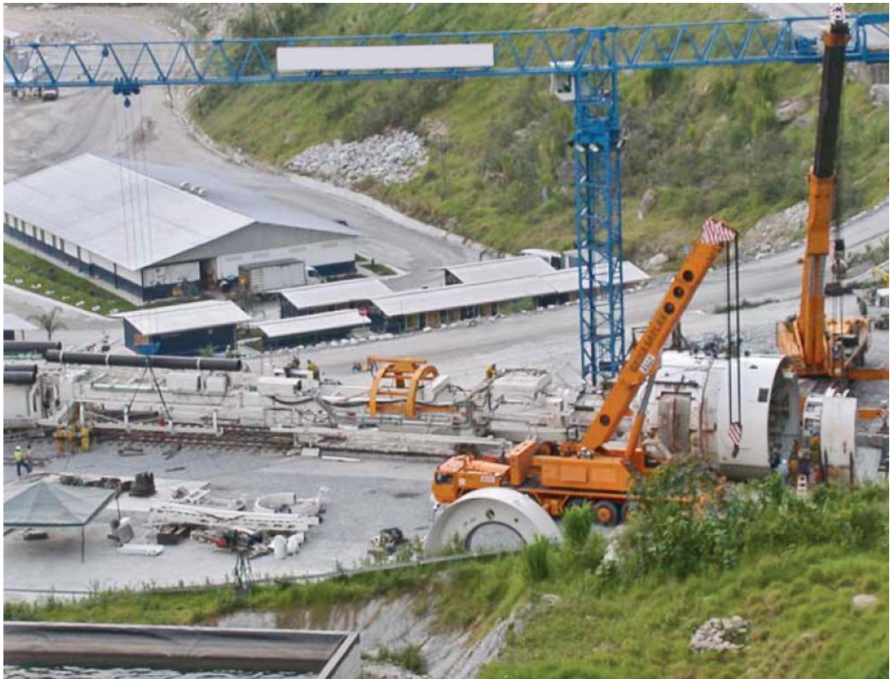
Foto 4. Montaje TBM Doble Escudo Central Hidroeléctrica San Francisco (Ecuador).
