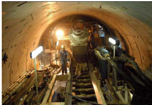
Foto 6. Vista de unos de los túneles del Arroyo Maldonado, justo atrás de la TBM. Se puede observar el revestimiento en base a dovelas prefabricadas de hormigón.
