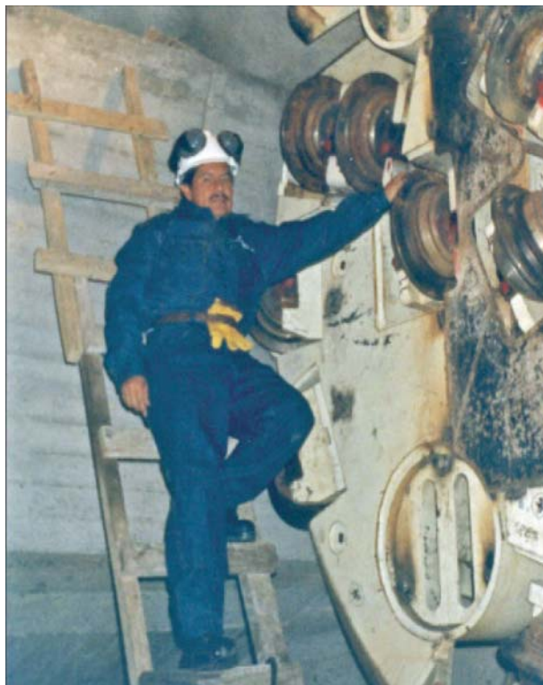
Foto 3. Cabeza de Corte de la TBM en su fase de montaje del Proyecto Yucán, Perú.
