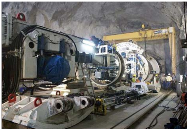
Foto 5. Montaje Subterráneo de la Cabeza de Corte de la Open TBM Robbins del Túnel de Traslase de Olmos (Perú).
