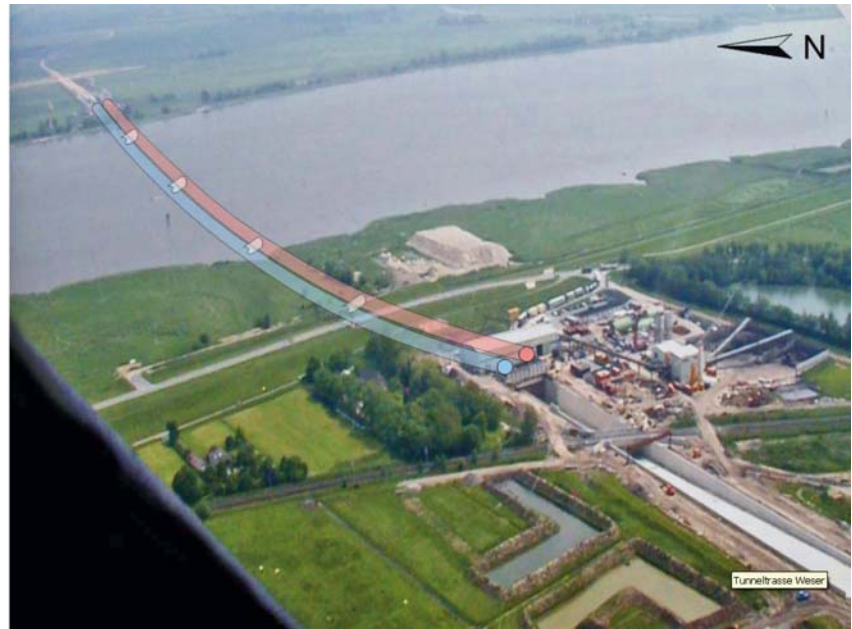
Foto16. Túneles para el cruce del Río Weser.
