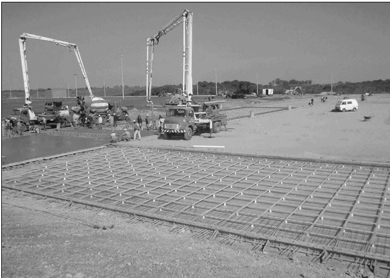
Figura 1: Vista de uno de los paños de pavimento postesado durante su hormigonado.
